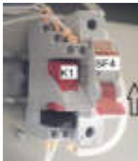
Рисунок 2 – Блокировка контактора КМ 1 в состоянии «Включено»
